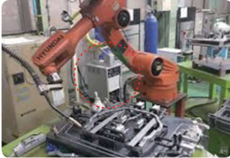
용접제어장치 셀 내부에 배치
